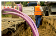
12 bares: soplado de cables y perforación
