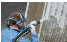
8,6 - 10 bares: granallado abrasivo
